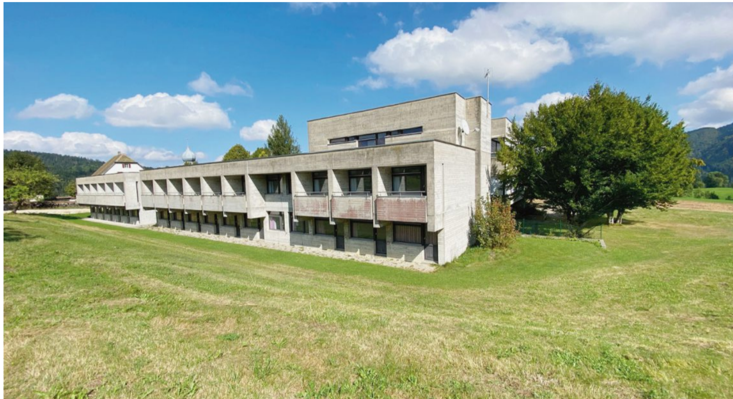
Der grosszügige Bau besticht durch seine Betonstruktur. Das Gebäude ist sehr gut unterhalten.
